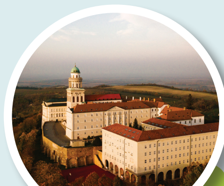
PANNONHALMI BENCÉS FŐAPÁTSÁG
